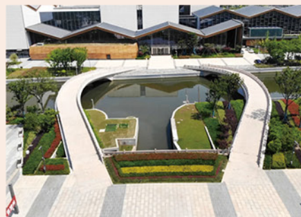
苏州工匠广场绿化及桥梁工程景观绿化工程
