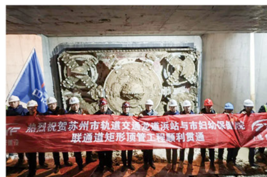
龙道浜与市妇幼保健院联通道顶管顺利贯通
