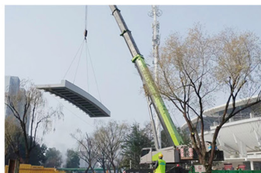
体育中心 4 号桥钢箱梁吊装
