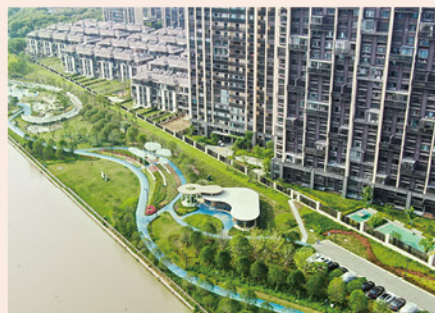
蠡塘河两岸景观提升改造（北岸）工程景观绿化
