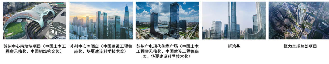
苏州中心南地块项目(中国土木工程詹天佑奖、中国钢结构金奖) | 苏州中心酒店(中国建设工程鲁班奖、华夏建设科学技术奖) | 苏州广电现代传媒广场(中国土木工程詹天佑奖、中国建设工程鲁班奖、华夏建设科学技术奖) | 新鸿基 | 恒力全球总部项目
