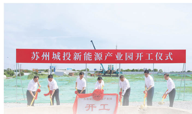
苏州城投新能源产业园（新建氢能智能设备制造基地项目二标桩基工程）开工
