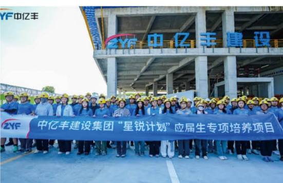
“星锐计划”2024年应届生专项培养项目走进智能建造工地
