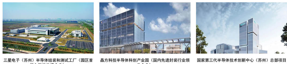
三星电子(苏州)半导体封装和测试工厂(园区首投入驻的外资企业) | 晶方科技半导体科创产业园(国内先进封装行业龙头企业) | 国家第三代半导体技术创新中心(苏州)总部项目
